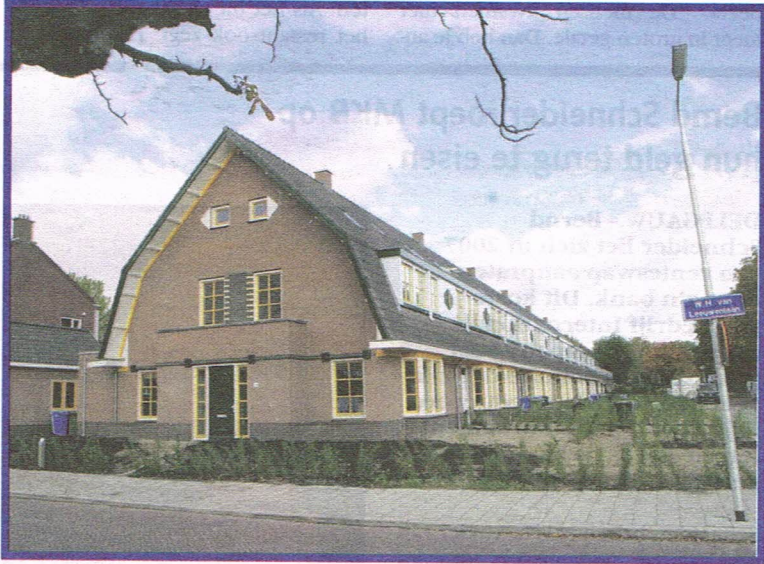
De nieuwbouw aan de W.H. Van Leeuwenlaan, volgens de architectuur van het Agnetapark.
